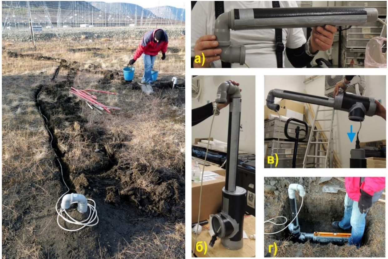
Рисунок 2.4 – Установка магнитных зондов на о. Свалбард (слева) и монтаж системы влаго- и ветрозащиты (справа, (а-г))
